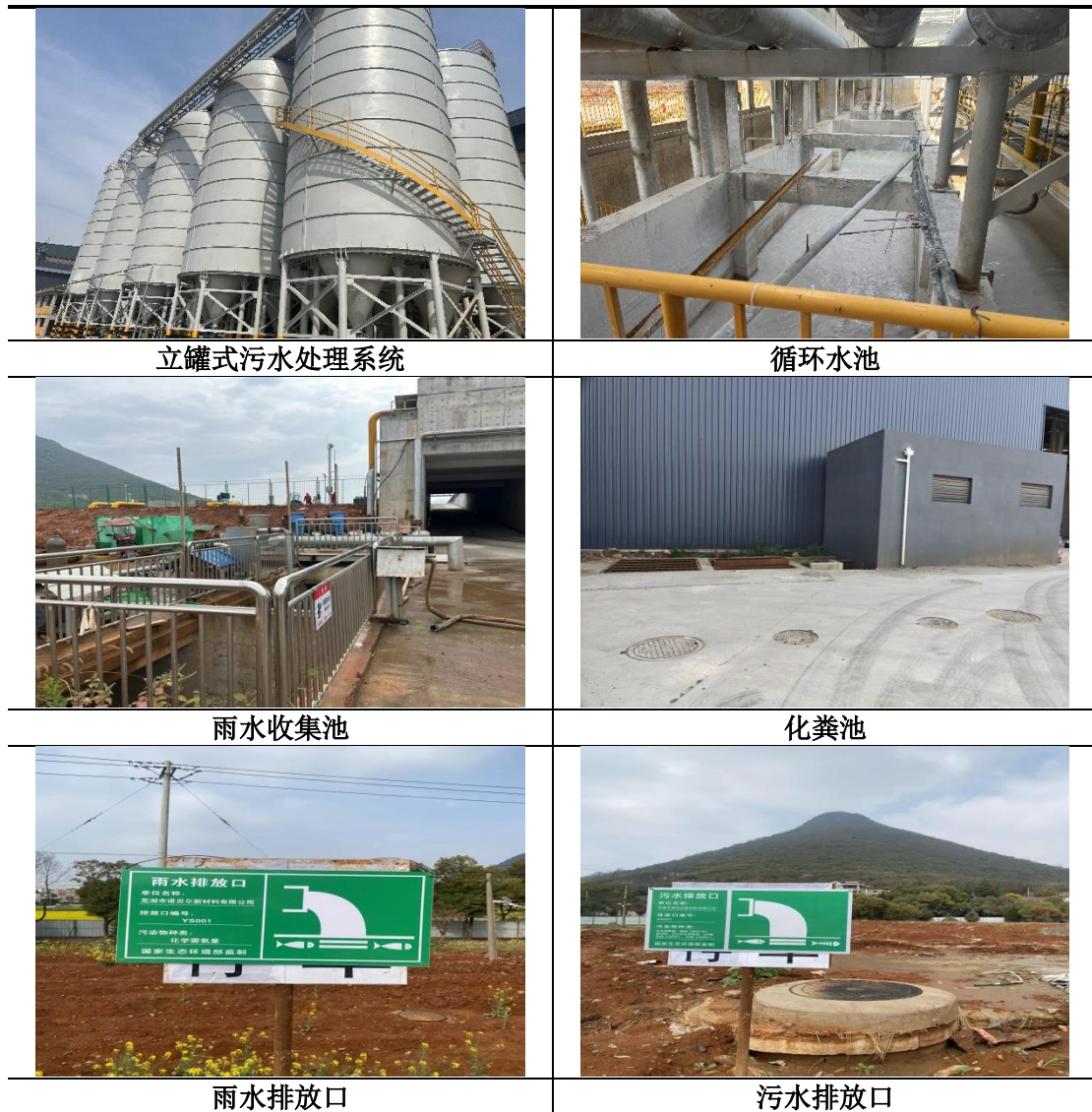
图 3-2 废水治理措施
