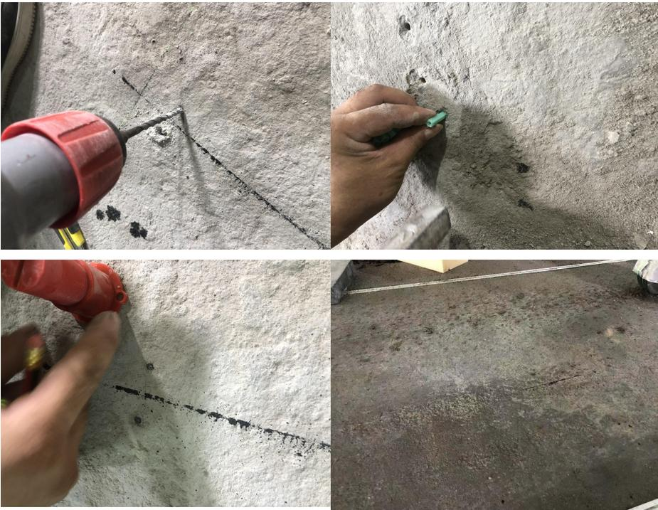
1 将找平定位器的定位桩安装在定点位置，调整好高度，安装定位杆，再根据定位杆高度用水泥砂找平。
