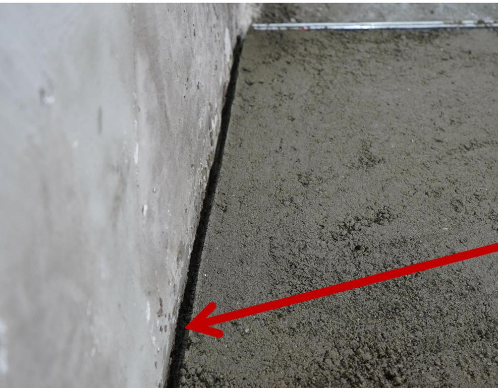
**留伸缩缝：**找平时，需在靠墙的四边，留出8-10mm宽度的伸缩缝的空间，施工时可用厚度为6-8MM的高密度泡沫条垫出缝隙。
