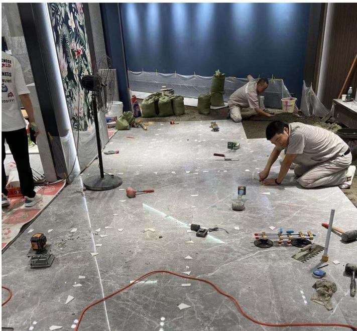
地下室，车库等易发生地基沉降的区域，如需精工密铺施工，需先用普通瓷砖先在基层用半干湿砂浆法铺一次（或使用钢筋水泥浇筑地面），提高地基的承载力和降低压缩性，再在瓷砖上铺岩板/瓷砖。
