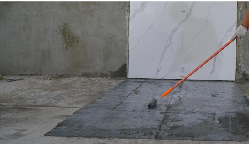
如果地面有裂缝或者渗水，应在刷水泥净浆前进行地固的刷涂。
