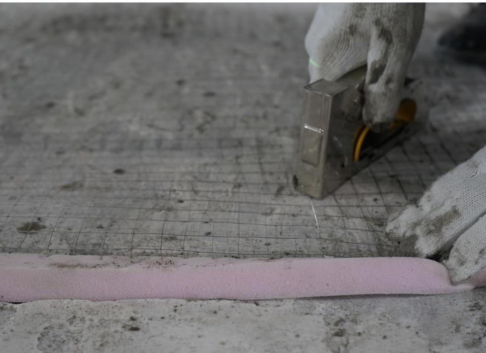
在已找平完成的基面上，钉上一层规格为10\*10mm的镀锌钢丝网，之后在钢丝网上再抹瓷砖胶施工
